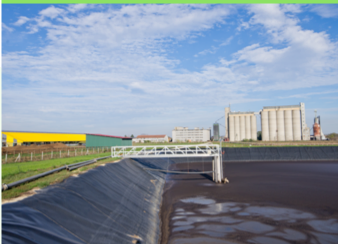
► Ilustración 53. Instalación exterior de almacenamiento de estiércol.
